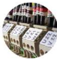
Suministro e Instalaciones Eléctricas Industriales
