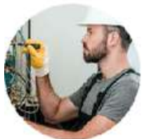
Suministro e Instalación de Protecciones Eléctricas
